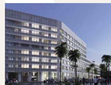
CONNEXIO (BNP Paribas Immobilier/UNOFI) Bureaux (11 000 m 2 )
