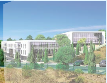
ARTEPARC SOPHIA (ARTÉA) bureaux sur 1 bâtiment (2 150 m²)
